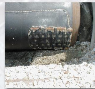
Ремонт трещин и надрывов
