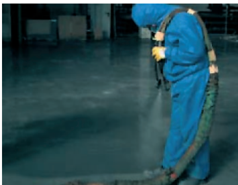
Нанесение напольного покрытия
