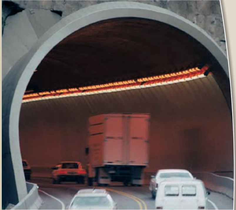
Защитное покрытие туннелей
