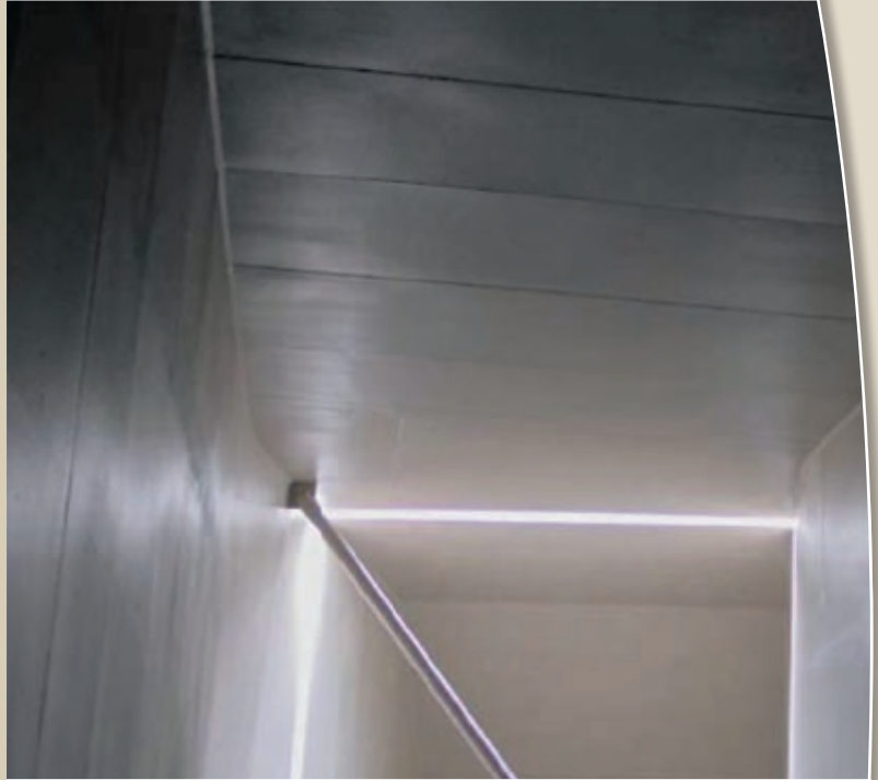
Канал очищенного газа
